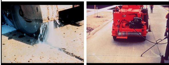
Saw & Hot Pour Seal Repairs
